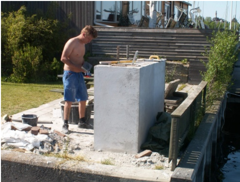
4. Der laves finish med klinker der limes på med Weber fliseklæb
